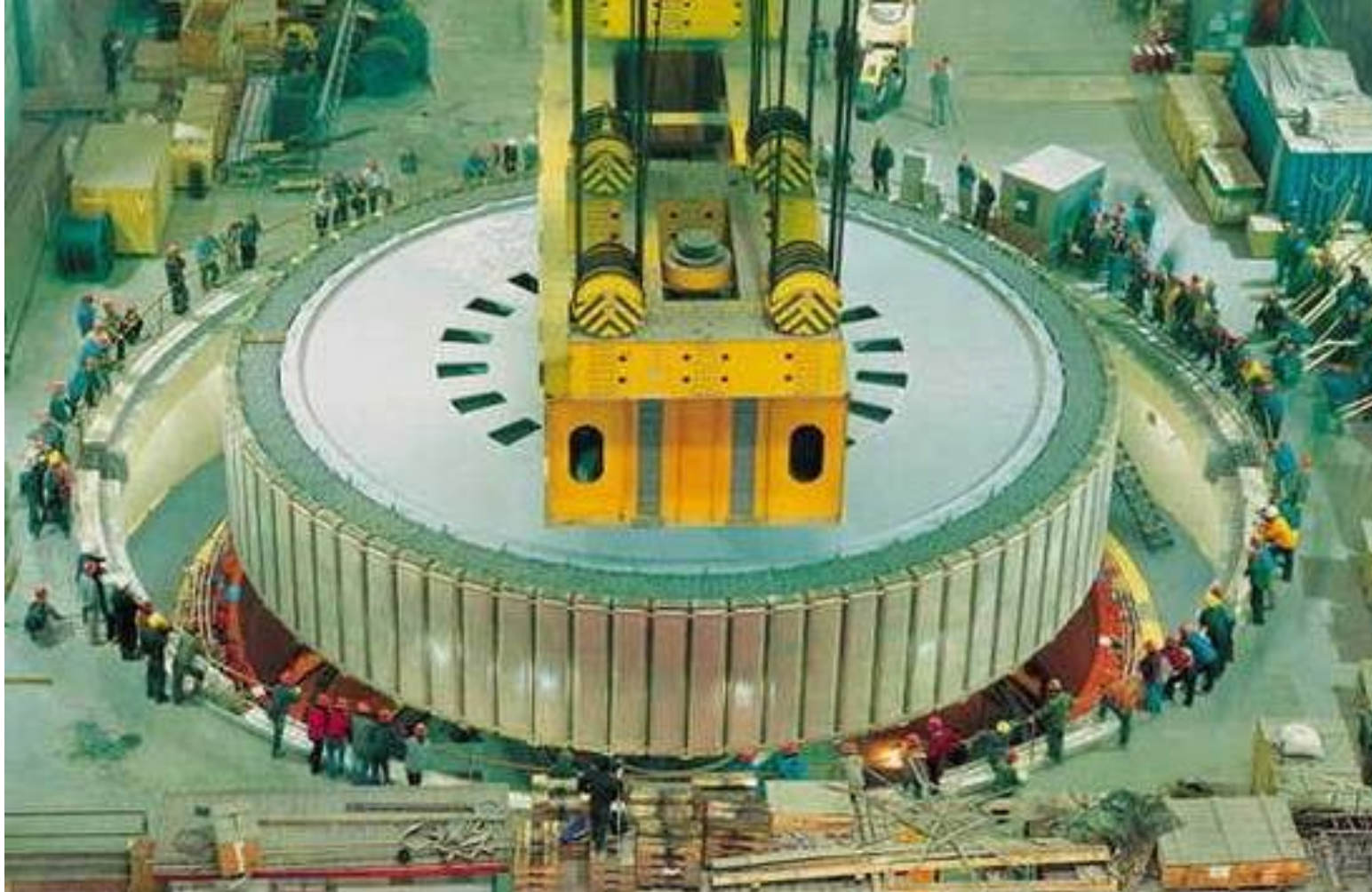
Presa de las Tres Gargantas – Parte superior del rotor de 700 MW en China
