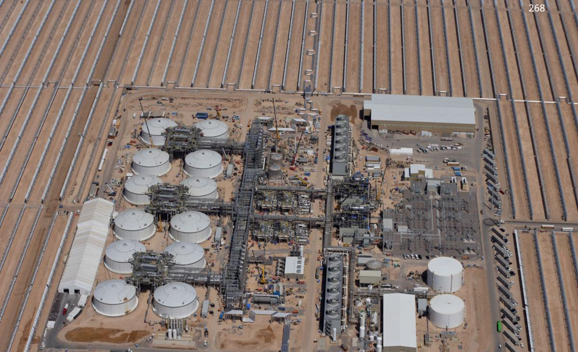
Solana Solar Arizona 280MW
