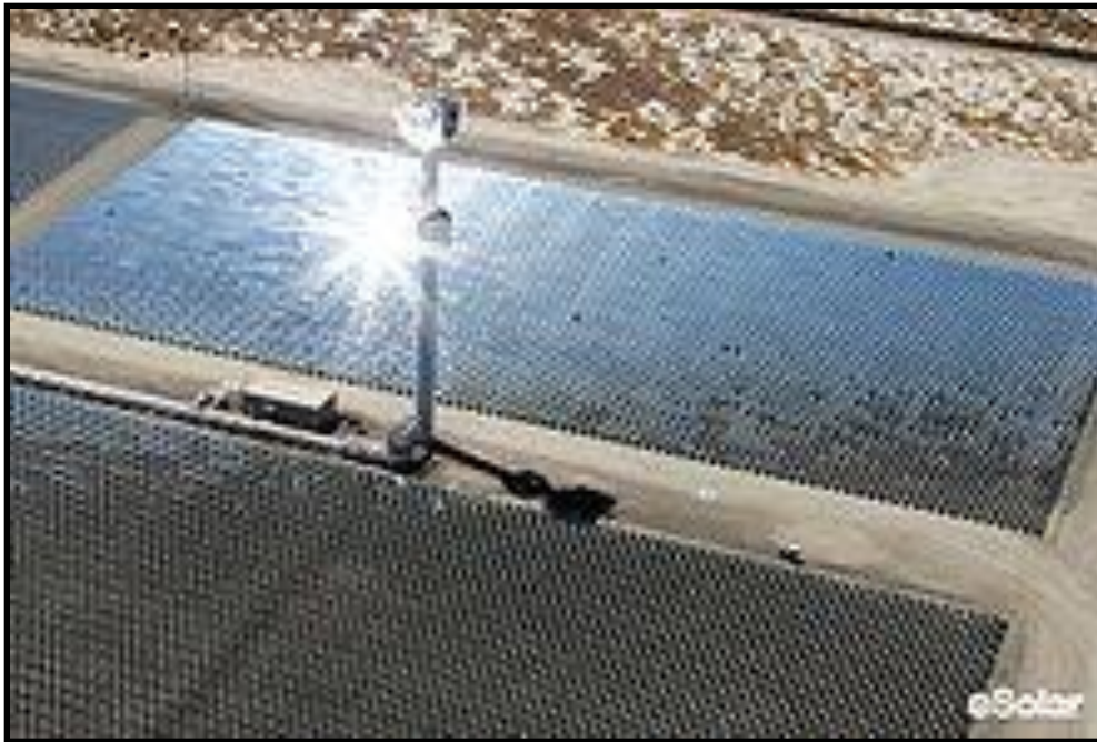
eSolar Térmica Sierra SunTower 5 MW Lancaster, CA
