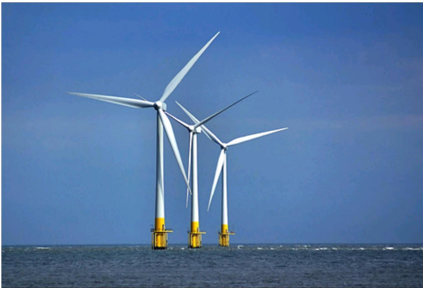
Aerogenerador de eje horizontal
